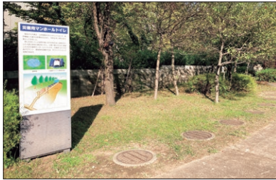
↑写真③ 港区立芝公園内の災害用マンホールトイレ 災害時にトイレになるマンホールトイレなど災害に備えた施設が設置されている。
