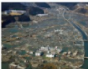
▲ 津波でほとんど建物が壊された沿岸地域(宮城県、南三陸町、2011年3月撮影)
