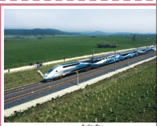
▲ ⑥ 大平原を走るTGV(フランス、パリ郊外) TGVはフランスの高速鉄道で、写真の列車はパリとリヨンをつ結ぶ。沿線には山が少なく、トンネルもほとんどない。
