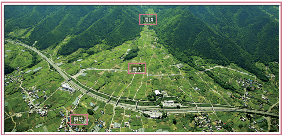
▲ 扇状地 (山梨県, 甲州市・笛吹市, 2010年撮影)
