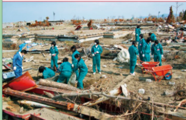
① 高校生ボランティア(2011年) 東日本大震災で被災した岩手県野田村でがれきの撤去を行っている。
