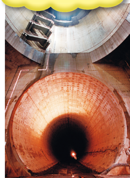
↑6 地下につくられた洪水対策用の調節池(東京都, 杉並区, 2011年撮影) 内径10m以上のトンネルに水を貯め、洪水を防ぐ。
